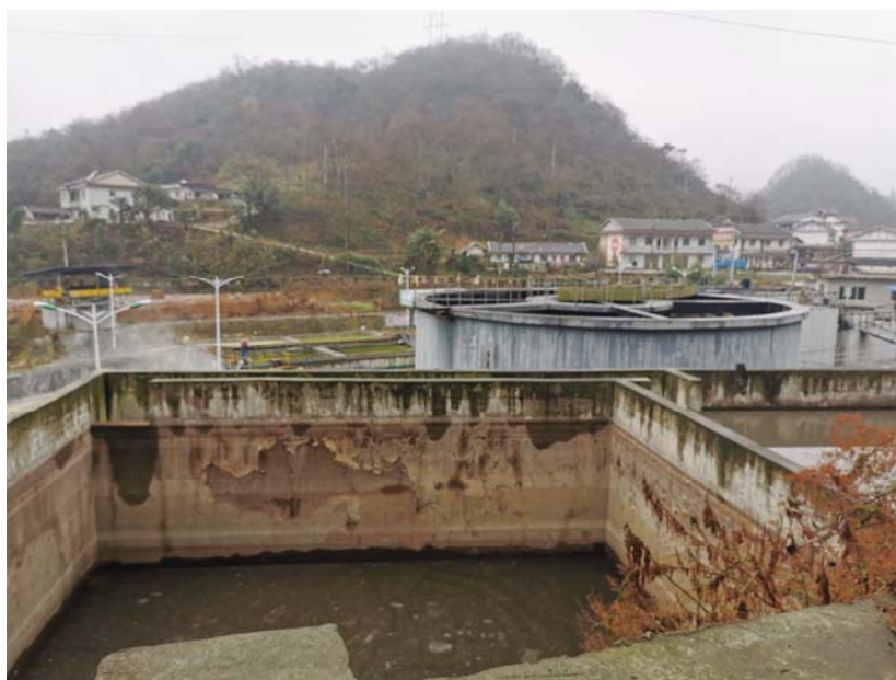
图4 现有污水处理站
